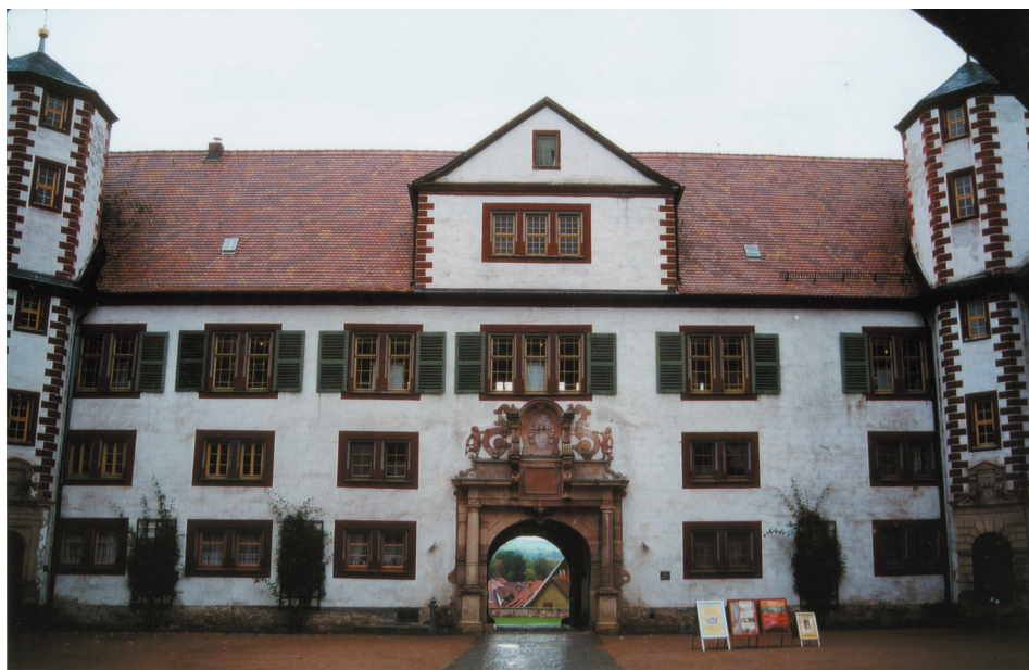
Farbtafel 107: Schmalkalden, Schloß Wilhelmsburg. Innenhof. Photo Matthias MÜLLER.
