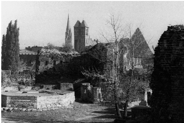
Abb. 39: Ruinen des Deutschordensschlosses in Thorn. Selten kann man wie hier den ursprünglichen Zerstörungsbefund und die funktionale Einbindung bewußt unzerstörter Baureste in die Stadtverteidigung wahrnehmen (gedeckter Turm in der rechten Bildhälfte mit dem auf diesen Turm hinführenden Gang), die ein planvolles Vorgehen der Stadt beim Schleifen des Herrschaftssitzes durch denkmalpflegerische Bewahrung noch heute erkennen läßt, nach: BOOCKMANN, Hartmut: Die Stadt im späten Mittelalter, München 1986, S. 172, Abb. 266.
