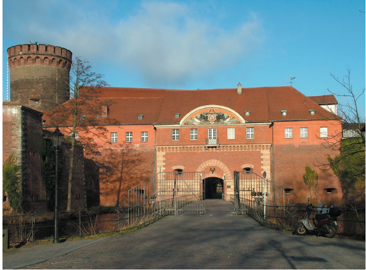
Farbtafel 41: Zitadelle Spandau (1560–1594), Toranlage mit anschließendem Kommandantenhaus sowie im Hintergrund der Juliussturm (Anfang 13. Jahrhundert). Photo Christine KRATZKE, 2005.
